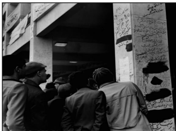
تصویر ۳: بخشی از ستون‌های خارجی ساختمان دادگستری مشهد (ساکماق: ۳۱)
