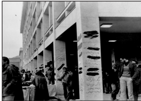
تصویر ۱: بخشی از ستون‌های خارجی ساختمان دادگستری مشهد (ساکماق: ۲)
